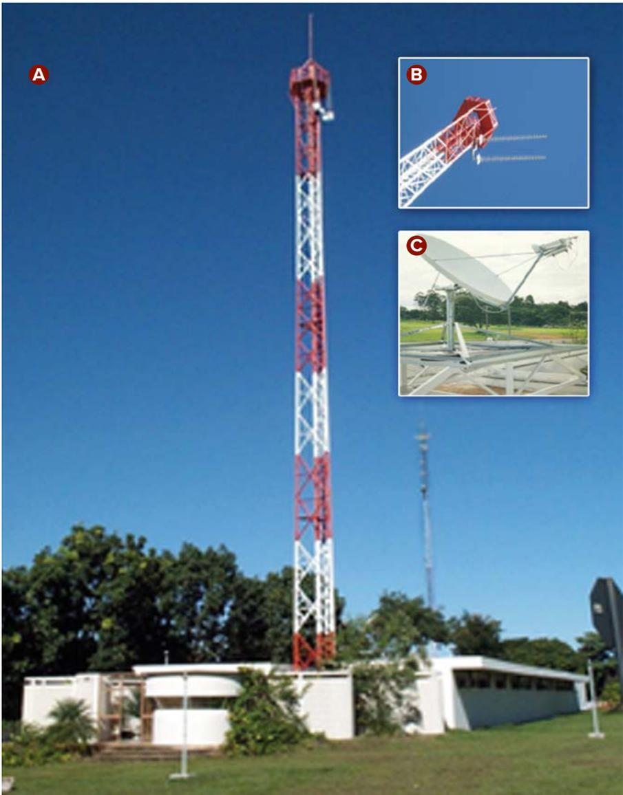
**Figura 20:** Estação Central de recepção, registro e análise de dados das estações do IMS operadas pelo Observatório Sismológico. (A) Vista do prédio e torre de recepção de dados, (B) Antena de alto ganho para recepção dos sinais das estações IS09 e PS07 e (C) Antena parabólica para retransmissão dos dados via satélite para o IDC em Viena.
