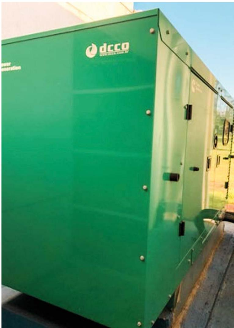
**Figura 21:** Grupo motor-gerador com potência de 54 KVA, que serve aos equipamentos da Estação Central.
